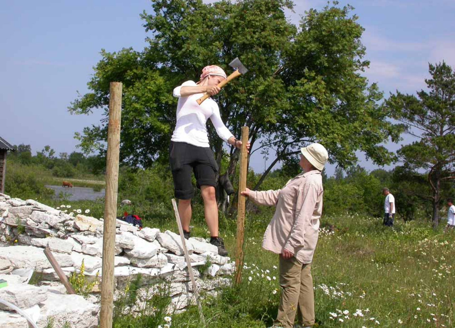
Kõrgusmärgid tulevad ka madala müüri kohale. Nivåmarkeringarna kommer också till de låga murarna.
