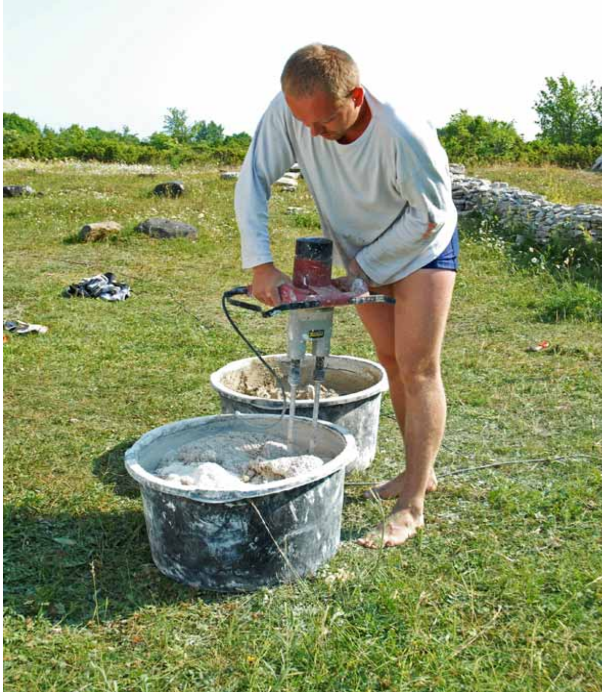
Müüride konserveerimiseks kulub 8 tonni lubimörti. Ätta ton kalkbruk går det åt till murarnas konservering.
