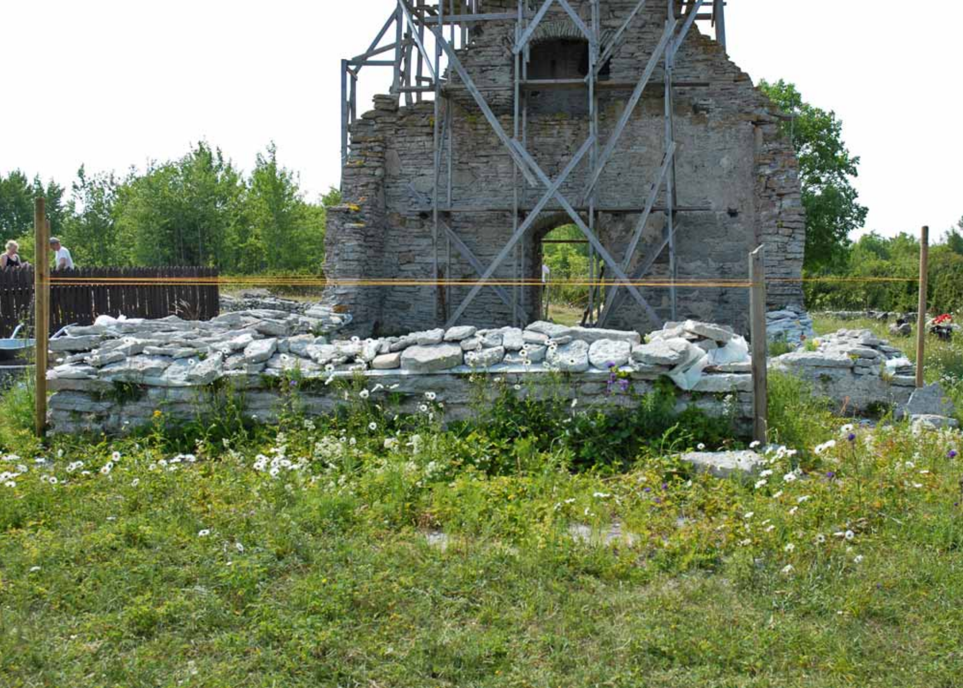
Nöörid on abiks kõrguste määramisel. Snörena används till att ange höjden.
